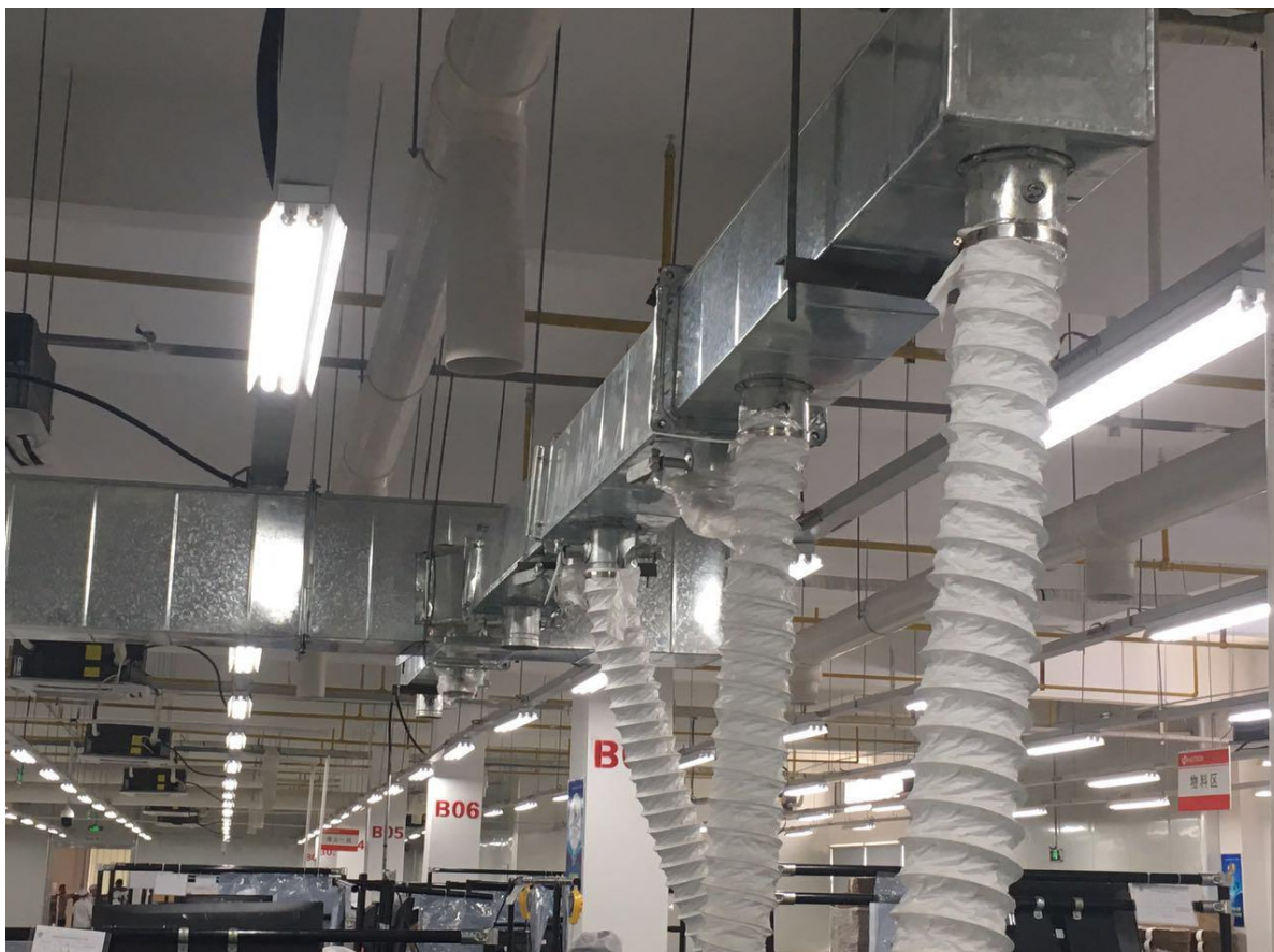
附图3 焊接工序负压收集过滤系统
